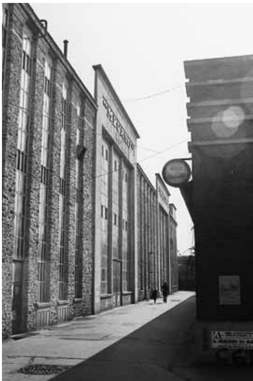
Pierre Trovel, Façade de l'usine Mécano occupée, 21 mars 1976, La Courneuve.
